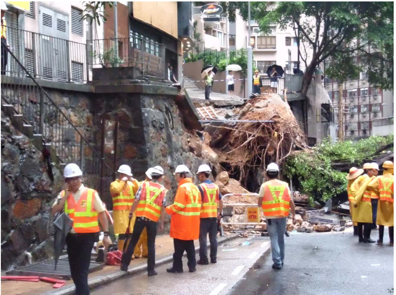
相片 2.2 - 事件中損毀的石牆部分
