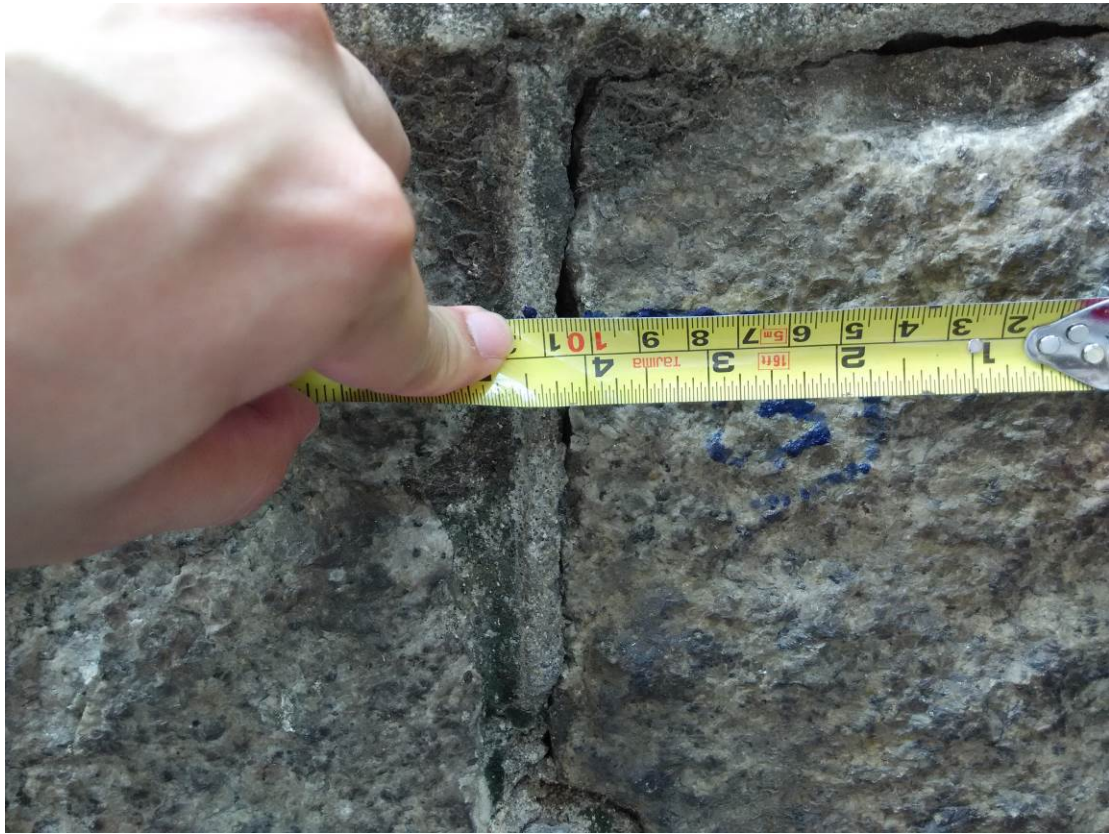
裂痕P.3 - 5毫米
