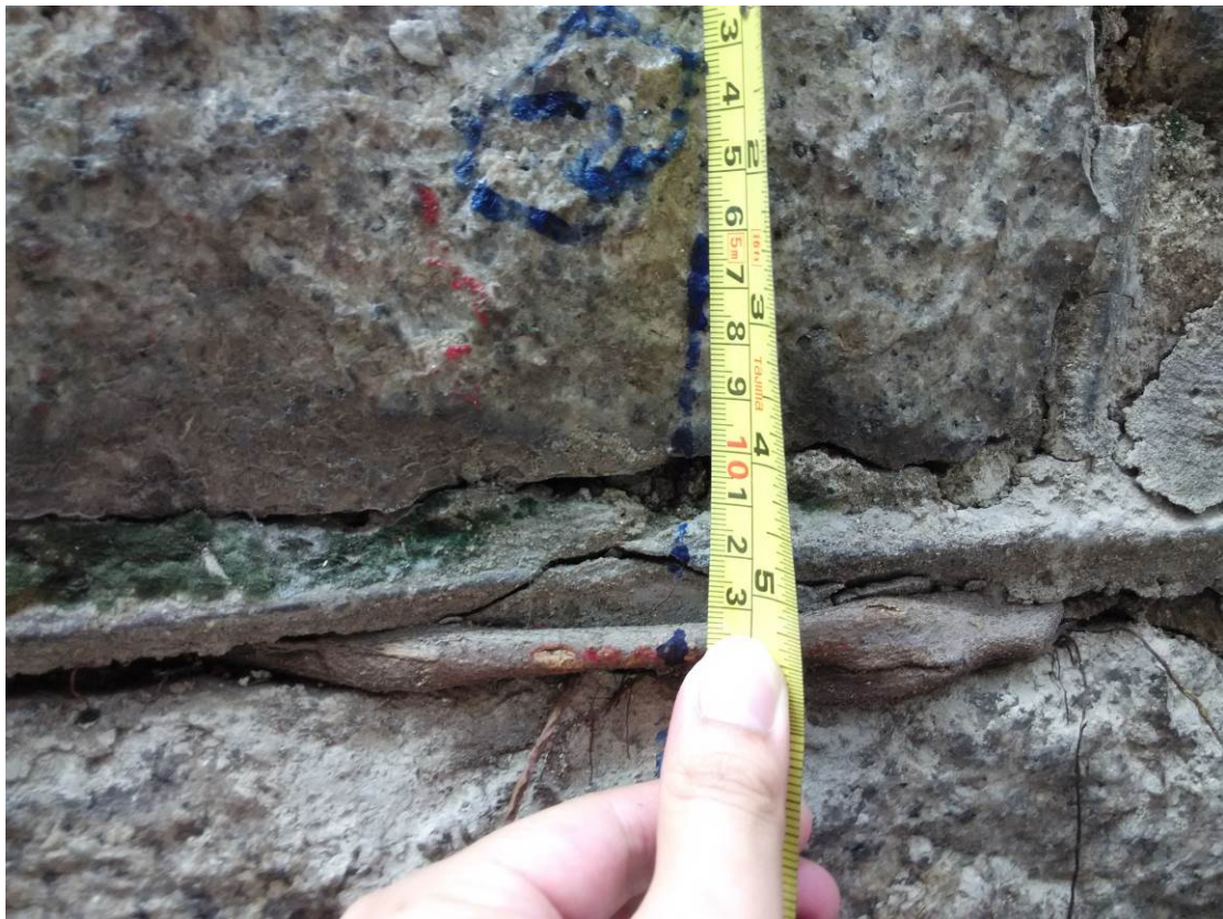
裂痕P.2 - 10毫米
