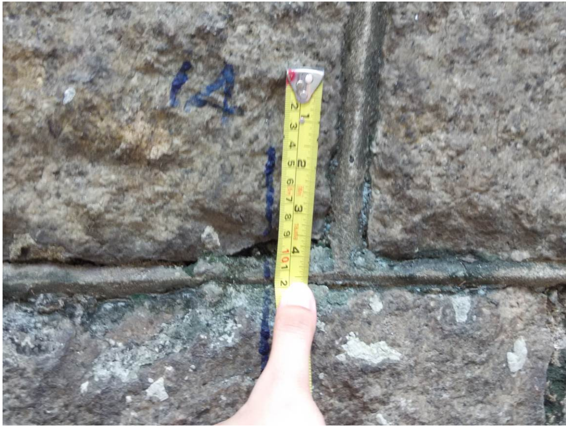
裂痕P.14 - 12毫米
