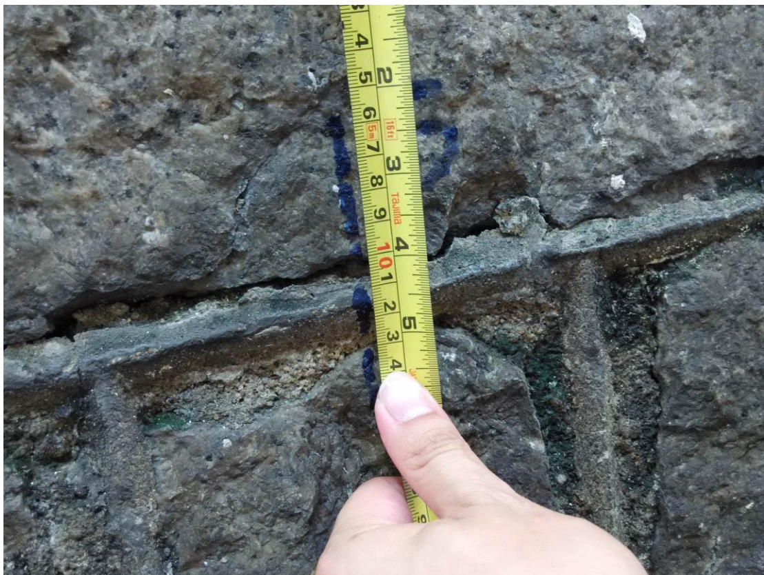
裂痕P.15 - 10毫米
