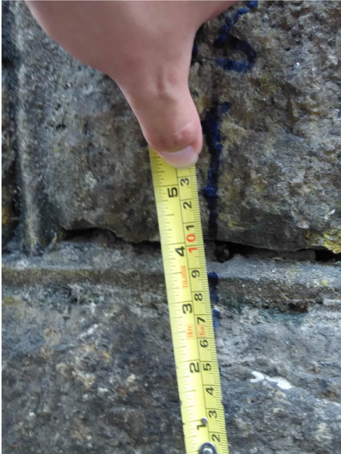
裂痕P.16 - 14毫米
