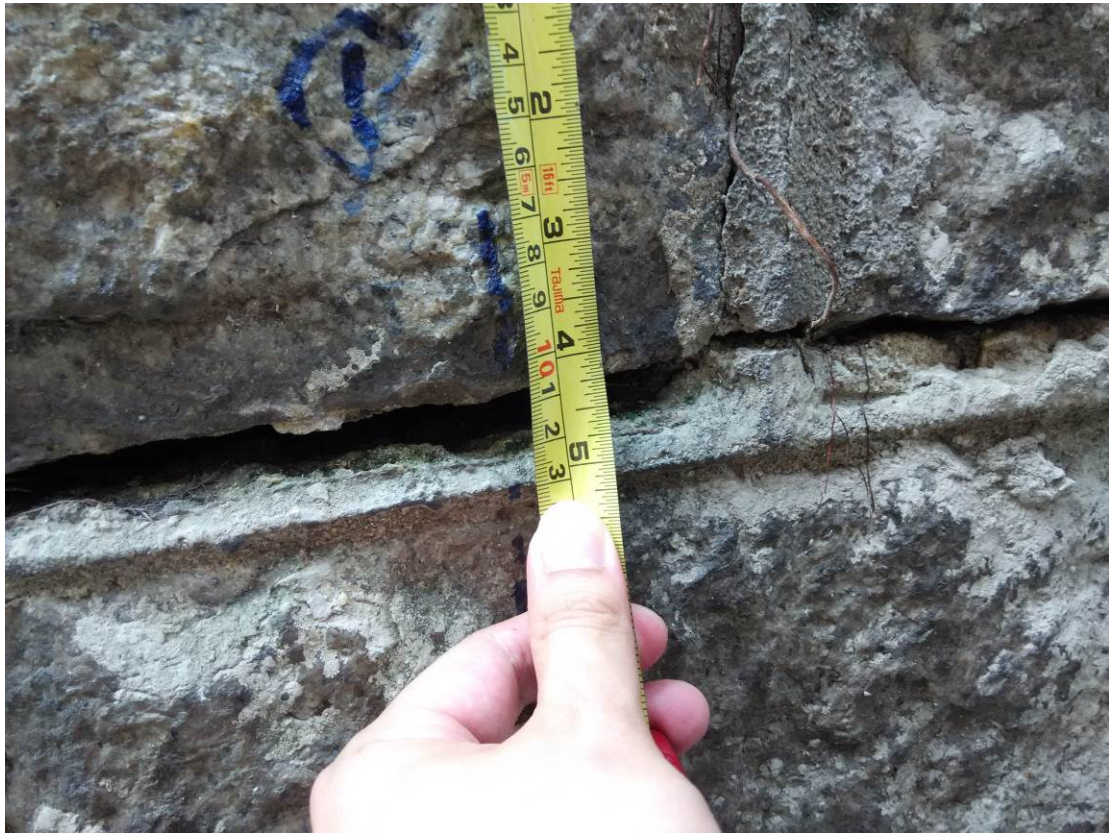
裂痕P.1 - 24毫米
